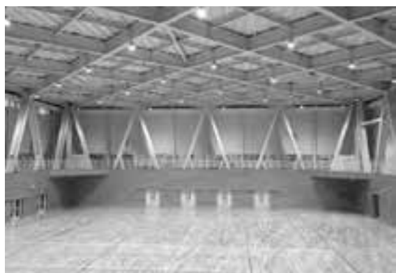
Fig. 3 体育館 内部全景
