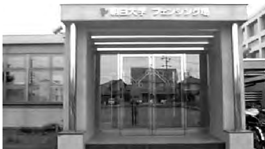
【朝日大学フェンシング場 外観】
