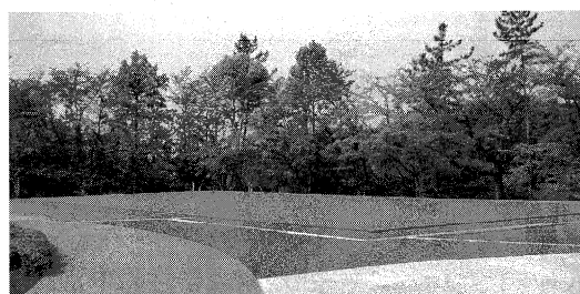
写真8:さまざまな材質でつくられた路面
